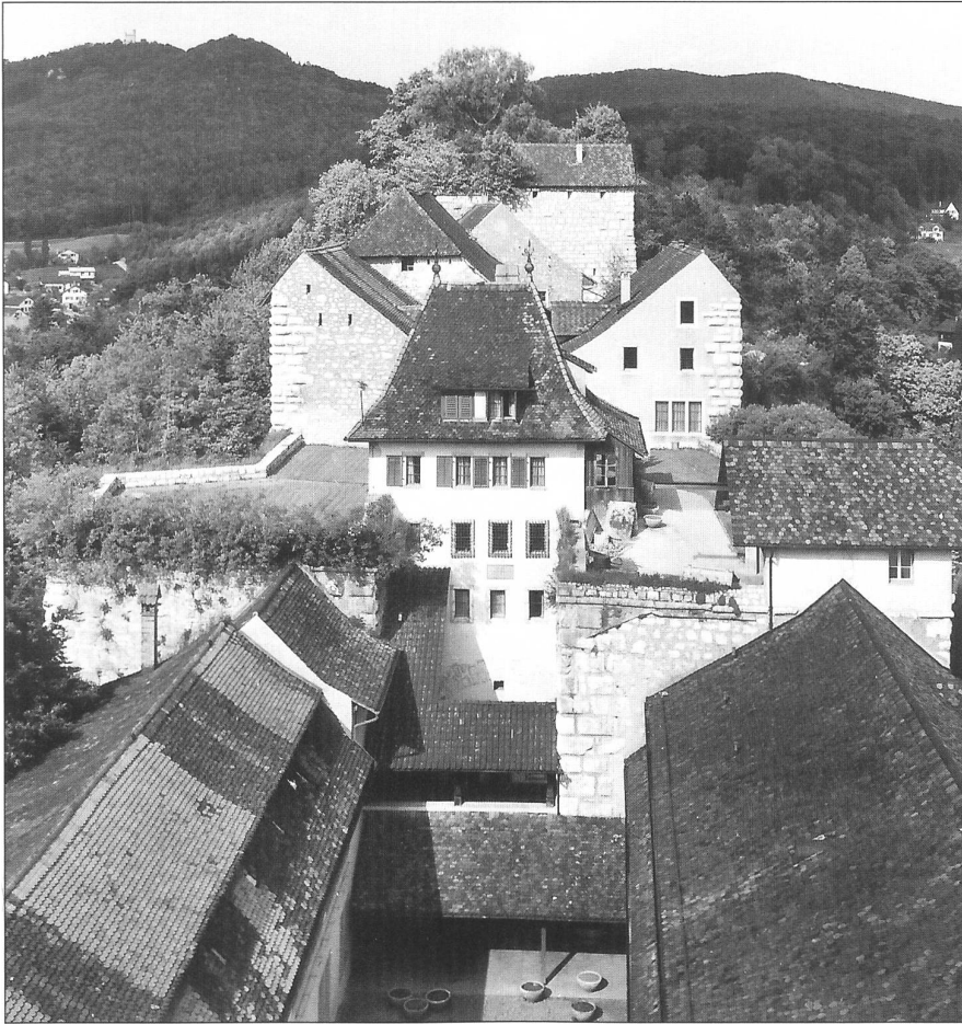
Abb. 3: Blick vom Schlossturm nach Nordosten auf die Festung Aarburg. In der Bildmitte befindet sich das «Laboratorium» mit den drei vergitterten Fenstern von Michelis Gefängnis und der darunter angebrachten Gedenktafel. Im Vordergrund der Paradeplatz, auf dem Micheli täglich eine Stunde spazieren durfte. Rechts neben dem «Laboratorium» die Terrasse, von der aus der Prospect Géométrique entstand. Das Lifthäuschen rechts in der Ecke der Terrasse ist erst neueren Datums (vergleiche Abb. 2). Photo von A. Gmünder, Heimatmuseum Aarburg.
