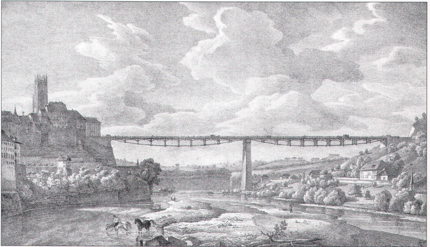
Abb. 8: Der vielseitig begabte Guillaume Henri Dufour projektierte 1825 diese Hängebrücke über den Saanegraben. Die faszinierende Holzkonstruktion, abgestützt auf Metallkabel, erschien aber den Freiburgern zu
