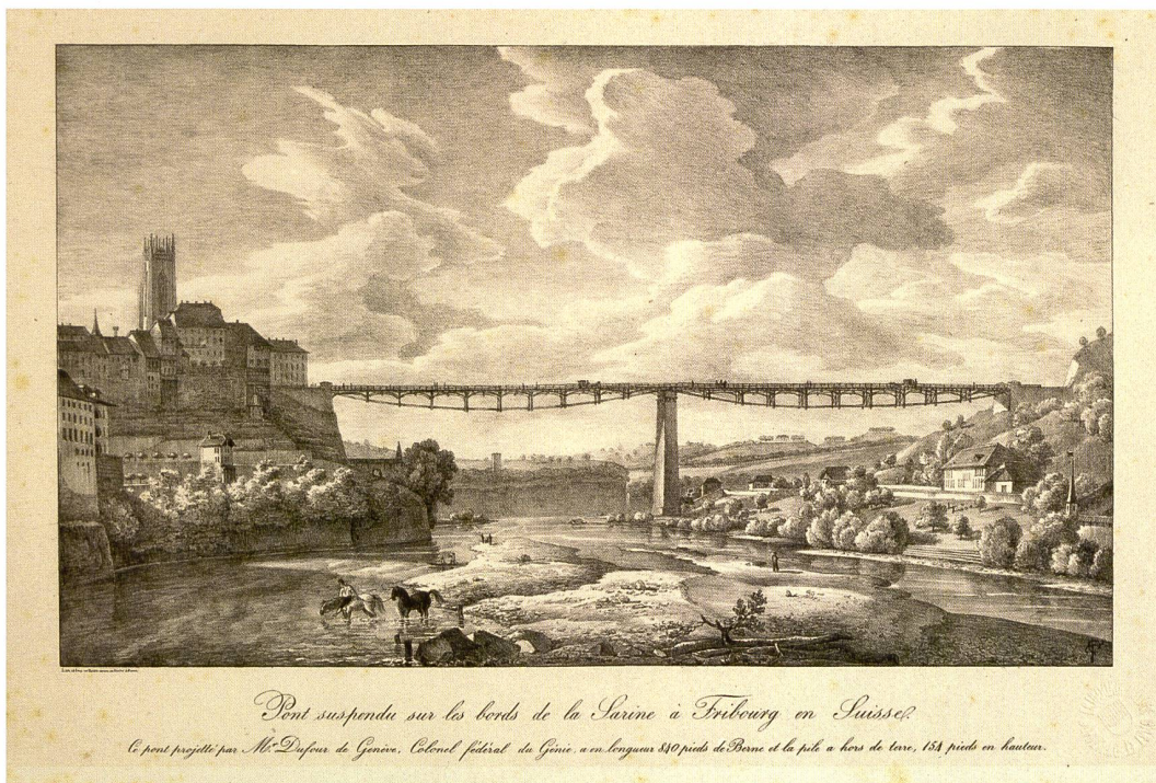
Abb. 7: Pont suspendu sur les bords de la Sarine à Fribourg en Suisse . Ce pont projeté par Mr. Dufour de Genève, Colonel fédéral du Génie a un longueur 840 pieds de Berne et la pile a hors de terre, 154 pieds en hauteur. Diese 1825 von Dufour projektierte Hängebrücke, eine auf Metallkabel abgestützte Holzkonstruktion, erschien den Freiburgern zu wenig elegant und wurde nicht realisiert. Lithographie von Philippe de Fegely, Format: 49 x 32,5 cm (Musée d'art et d'histoire Fribourg, 10558 001).
