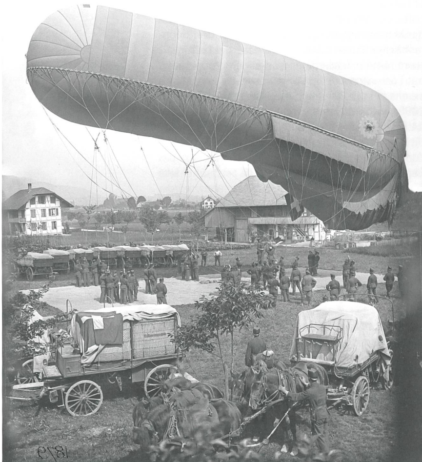
Abb. 28: «Aero-Photogrammetrie: Fesselballon der Ballonkompagnie, mit Park; kurz nach der Füllung». Glasplattennegativ, 9x12 cm, Photo: Ingenieur Johann Ganz (1879–1952) (swisstopo, Bildsammlung, Technische Aufnahme 1879)
