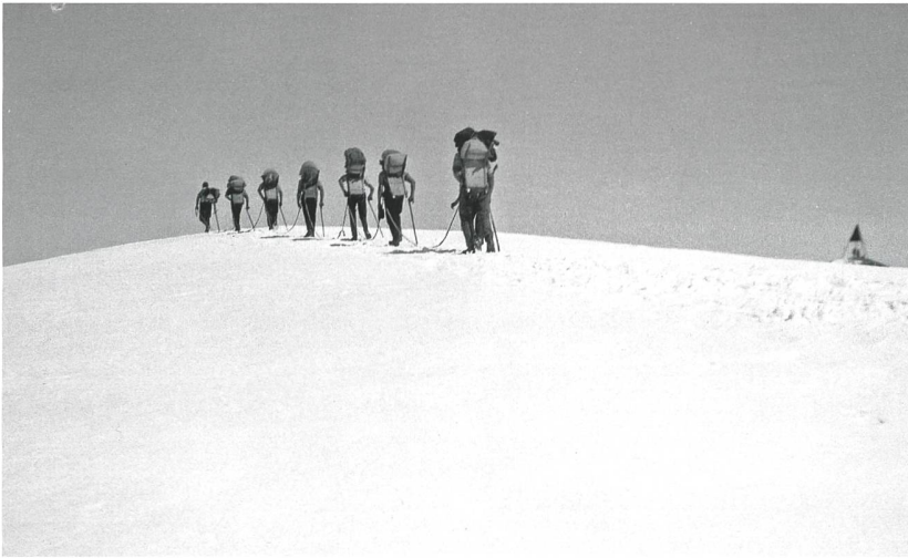
Abb. 70: Eine technische Aufnahme mit künstlerischen Qualitäten: Trägerkolonne mit Zement und Sand im Aufstieg zum Triangulationspunkt 1. Ordnung Titlis für die Reparatur des Pfeilers und der Pyramide. Aufnahme von Ingenieur Werner Lang, 1923. Filmm negativ 12x9 cm (swisstopo, Bildsammlung, technische Aufnahme 2321).
