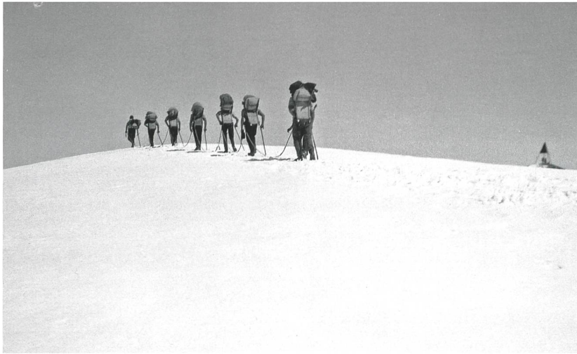
Abb. 70: Eine technische Aufnahme mit künstlerischen Qualitäten: Trägerkolonne mit Zement und Sand im Aufstieg zum Triangulationspunkt 1. Ordnung Titlis für die Reparatur des Pfeilers und der Pyramide. Aufnahme von Ingenieur Werner Lang, 1923. Filmm negativ 12x9 cm (swisstopo, Bildsammlung, technische Aufnahme 2321).
