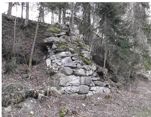
Abb. 3: Überreste des südlichen Widerlagers (Photo: Guy Schneider, Via Storia).
