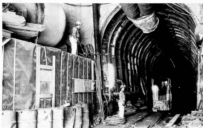
Der Schweizer Verschlinger... Ursprünglich auf 70 Millionen budgetiert, werden die Kosten des Furka-Tunnels 300 Millionen überschreiten.
