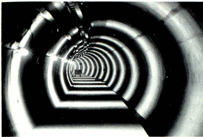
Für die LEP-Beschleunigeranlage wurde ein Ringtunnel mit einem Umfang von 27 Kilometern gebaut. Die Tunnelröhre hat einen Durchmesser von 3,8 Metern. (Foto: Cern)
