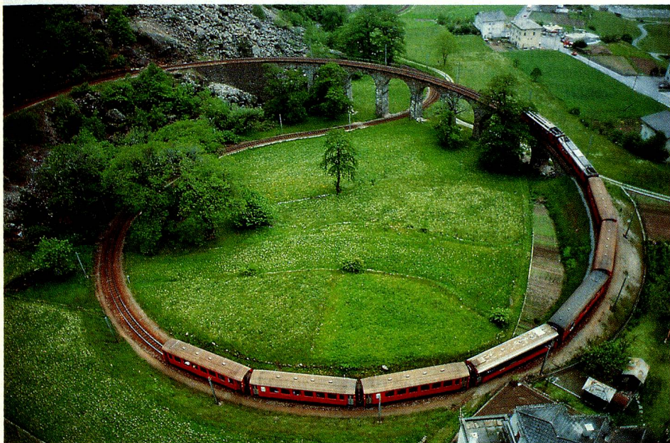
Kreisviadukt zur Überwindung der Steigung bei Brusio im Puschlav.
