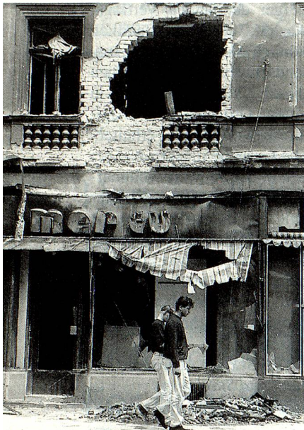
Durch Artilleriebeschuss zerstörte Gebäude in Sarajevo: Auch im früheren Jugoslawien haben zahlreiche Auslandschweizerinnen und Auslandschweizer ihre Existenz verloren; die wenigsten waren dagegen versichert! (Foto: Keystone)
