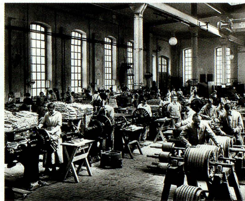
1915. BBC-Werk Münchenstein. Anfertigen der Spulen, die in Lokomotivmotoren eingesetzt werden.
