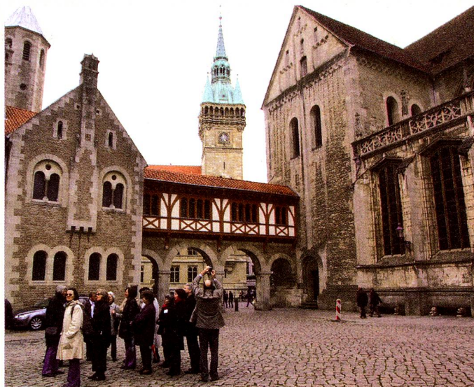
Schweizer auf dem Burgplatz: Eine Stadtführung durch das historische Zentrum von Braunschweig war ein Muss.
