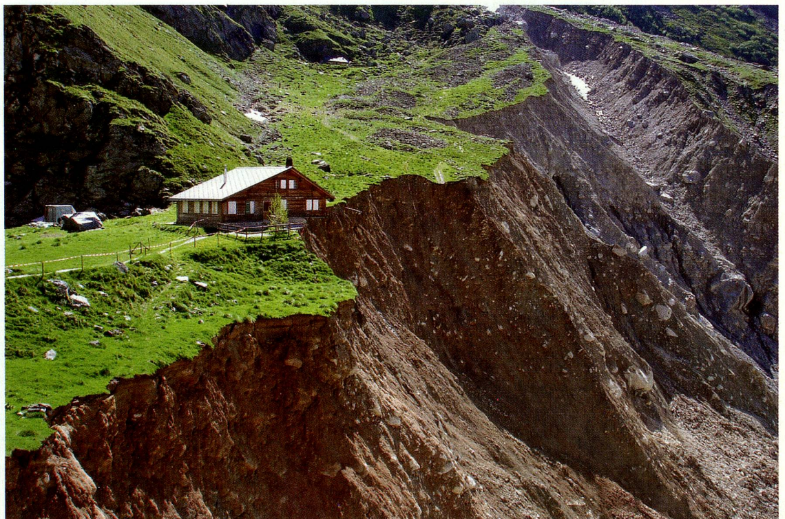
Im Mai 2005 stand die Stiereggütte plötzlich am Abgrund. Eine riesige Moräne hatte sich gelöst, weil sich der Untere Grindelwaldgletscher massiv zurückgezogen hatte. Die Stiereggütte wurde danach abgebrochen
