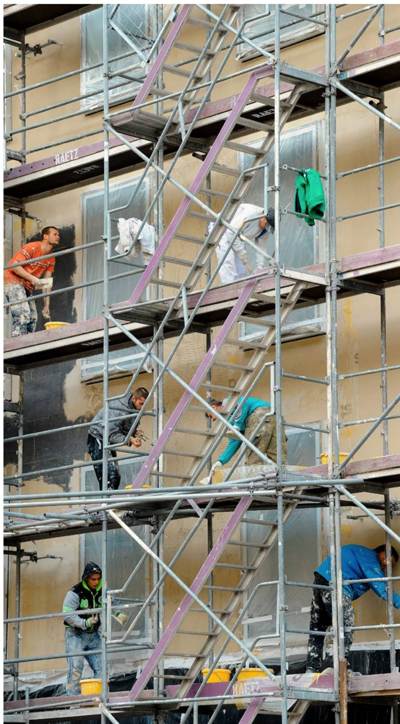
Der vorliegende Rahmenvertrag würde es ausländischen Firmen erleichtern, in der Schweiz Aufträge auszuführen – zum Beispiel auf hiesigen Baustellen. Entsprechend gross ist die Sorge der Gewerkschaften, dies bedrohe das heutige Lohnniveau. Foto Keystone
