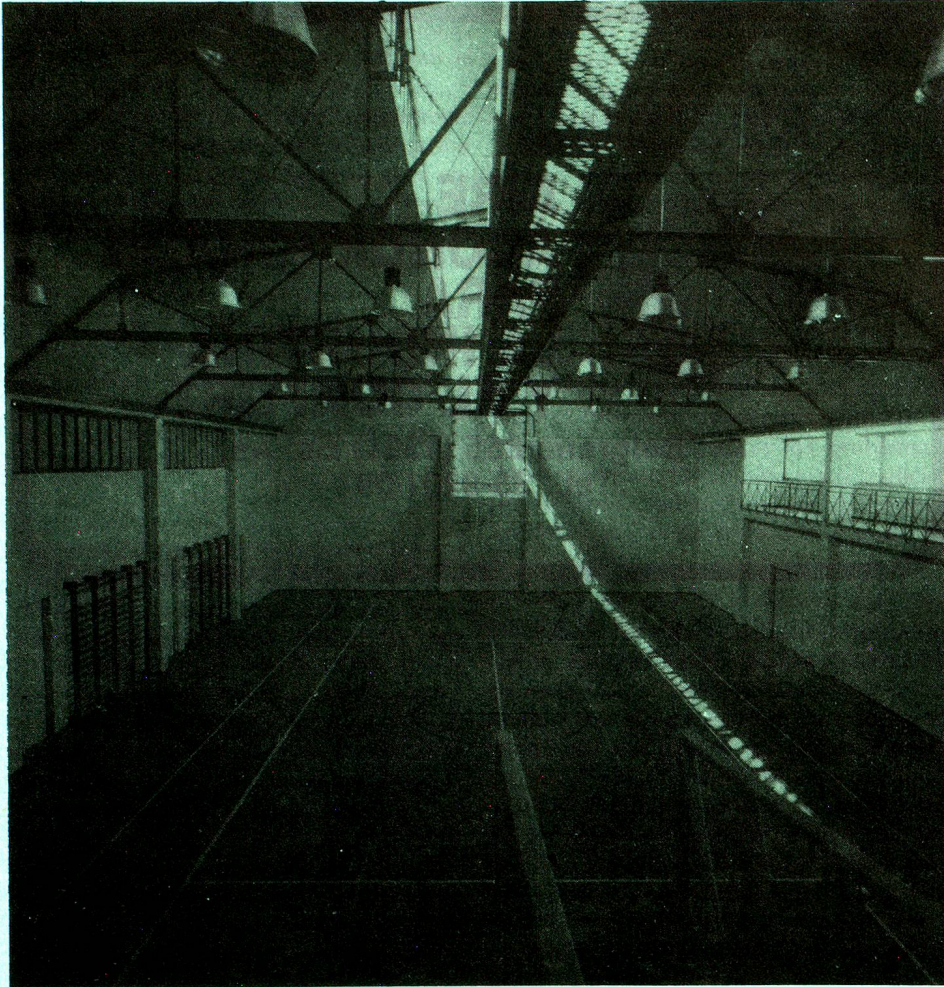
Vista interior del gimnasio
