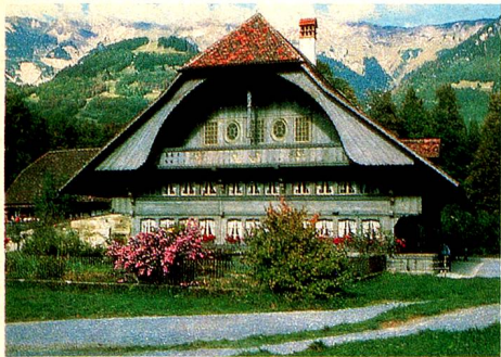
Casa multifuncional de Ostermundigen (Ber-na) 1797. Casa de labranza acomodada, construida por el teniente capitán Bendicht Gosteli. (Fotos: a la disposición)
