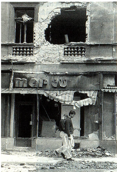
Edificio destruido por salvas de artillería en Sarajevo: numerosos suizo(a)s que vivían en ex Yugoslavia quedaron arruinados sin estar asegurados adecuadamente.
