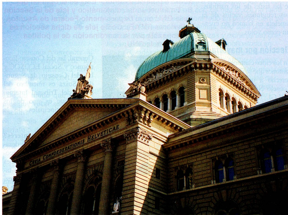
El Palacio Federal en Berna. (Foto: R. Nyffeler)
