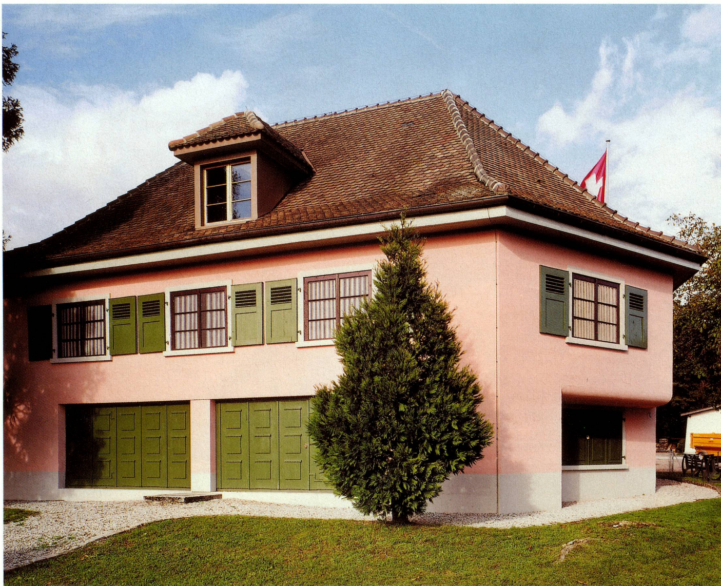
Residencia, 1940, búnker de infantería, Gland VD: Construcción maciza con techo de copete y cubierto de tejas, con lucarna. Detrás de las ventanas falsas hay pintadas cortinas directamente sobre el cemento. Hoy el búnker es usado como museo.
