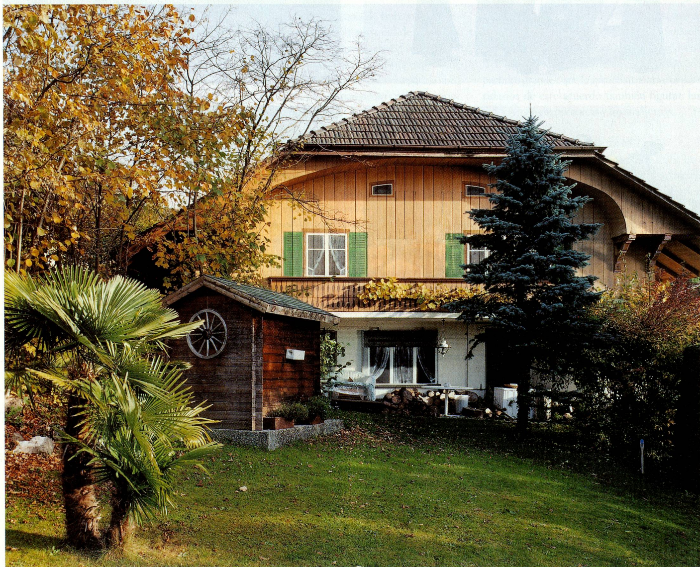
Chalet, 1941, búnker de infantería, Hilterfingen BE: construcción de hormigón con techo de copete truncado e interior abovedado. Las ventanas, los postigos y la barandilla de balcón están pintados sobre el recubrimiento de madera. Bajo el retroceso se encuentra la tapa de la tronera que parece una ventana con persianas semiabiertas.
