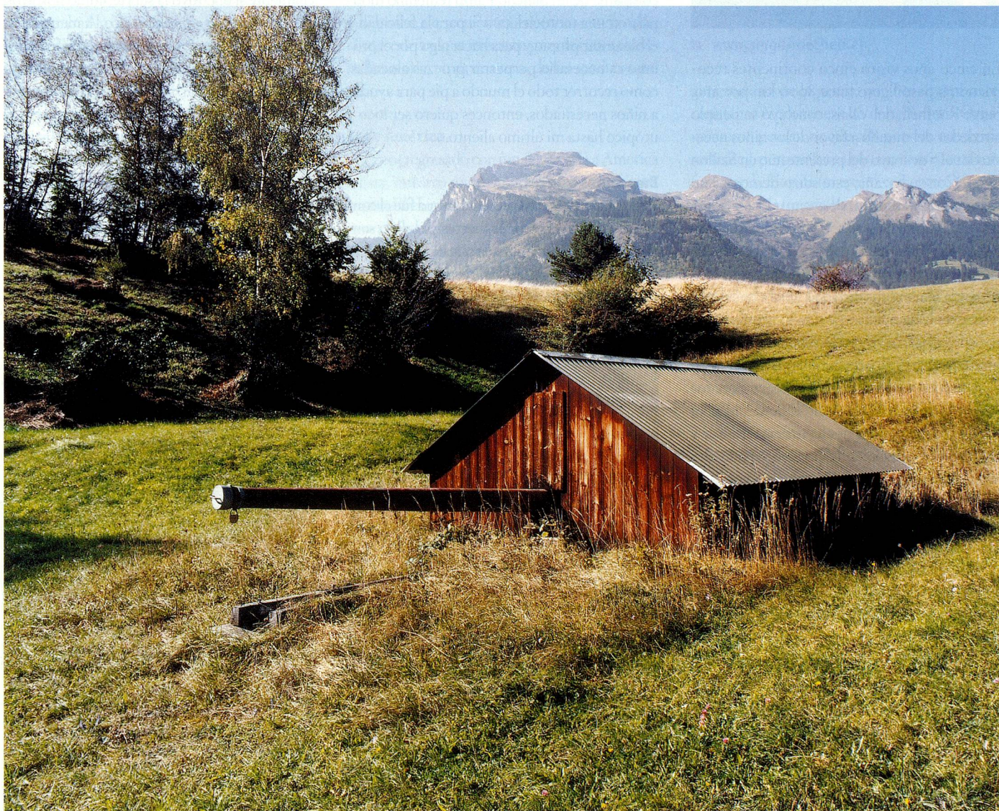
Chozo, 1939-43, Torre blindada de la fortaleza de Magletsch, Oberschan SG: La torre blindada está cubierta por un encofrado de madera y un techo de chapa ondulada. El cañón no está revestido y lleva una tapa en su boca.
