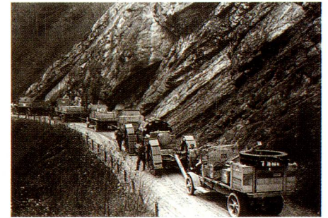
Historia de la industria: camiones de Brown Boveri transportan piezas de generadores al Wägitalersee en 1924
