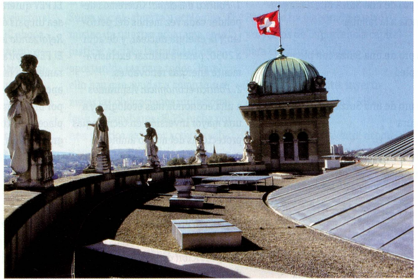
En el tejado del Palacio Federal
