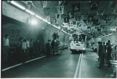
Apertura del túnel vial del San Gotardo el 5/9/1980.
