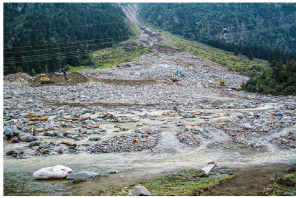
En la tormenta de 2005, más de 500 000 metros cúbicos de piedra y grava se precipitaron por el desfiladero de Rotlouwi y sumergieron el valle.
