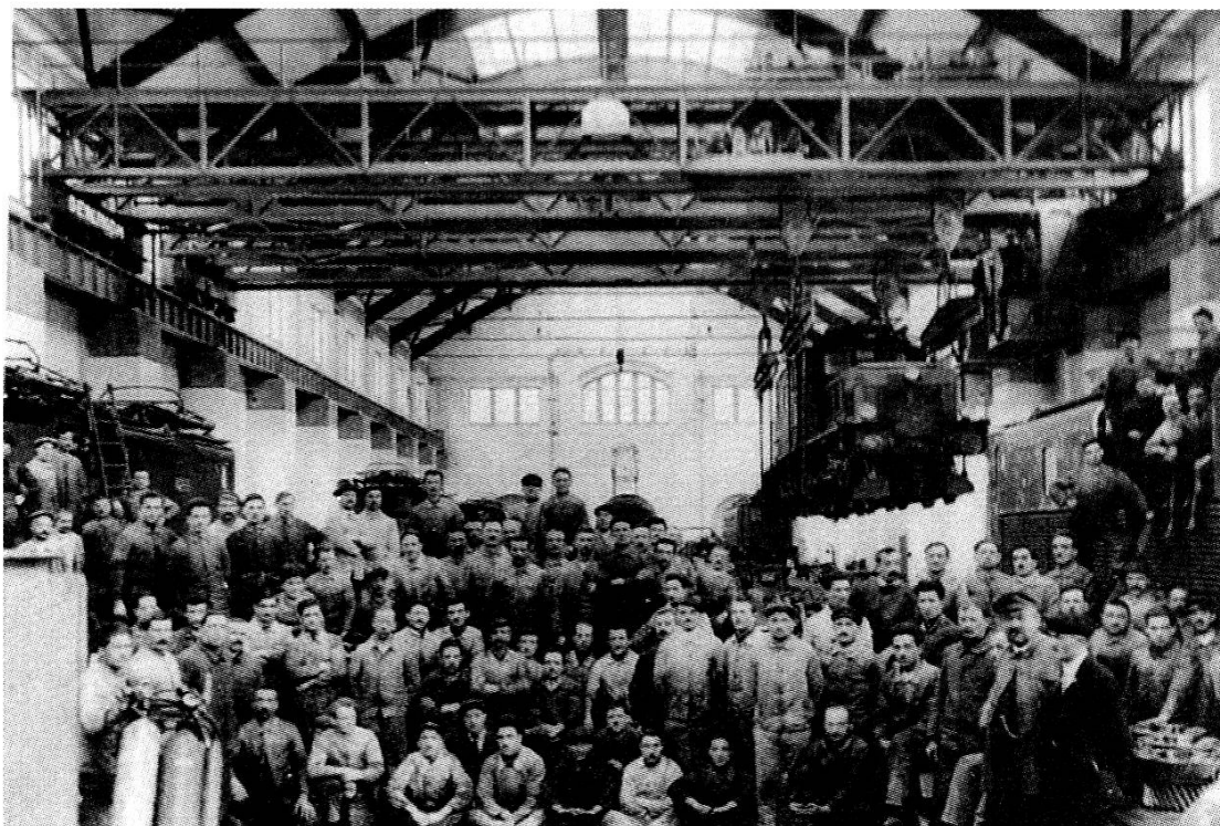
Construction réalisée en 1919 pour l'assemblage des locomotives électriques ; photo publiée dans Il Ticino e i suoi fotografi , Berne, Benteli, 1987, p. 186.
