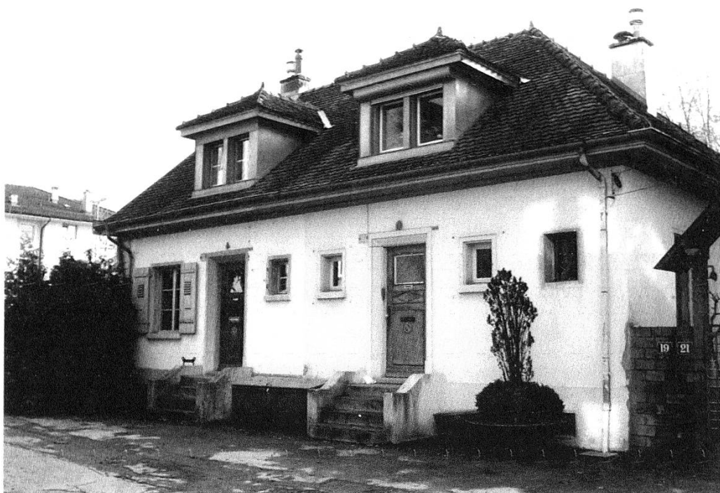
Fig. 1. Lausanne, Route de Berne 19-21, 1923, Gilliard & Godet arch. pour la société coopérative La Maison Familiale, façade Nord (photo novembre 2008).
