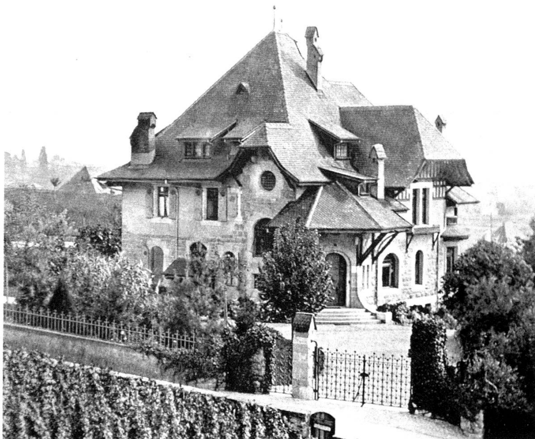
Fig. 6. Vevey, villa Koelher-Mooser. Vue générale. La chambre de bonne se trouve sous la toiture qui couronne le porche d'entrée (Bulletin technique de la Suisse romande, 1912).
