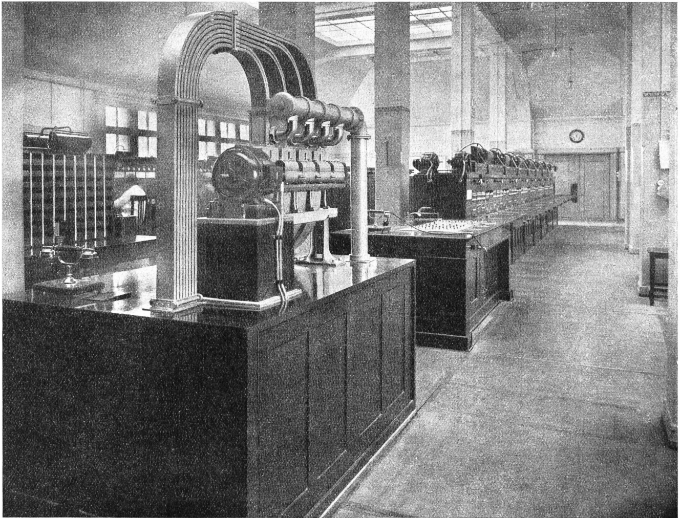
Fig. 5. Rohrpostempfänger und -Sender in Zürich.
