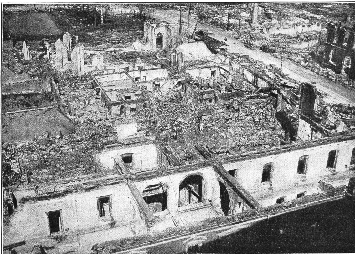
Ruinen des Fernsprechamtes Honkyoku in Yokohama.
