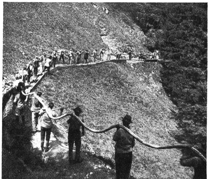
Fig. 5. Kabeltransport. (Aufnahme J. Kamn.)
