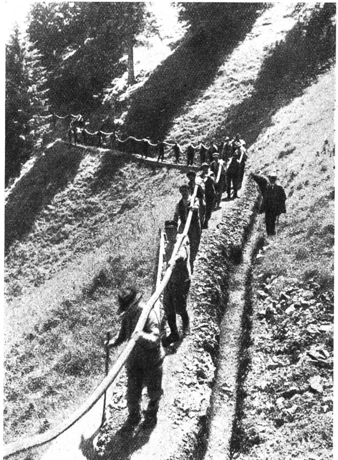
Fig. 7. Kabeltransport.
