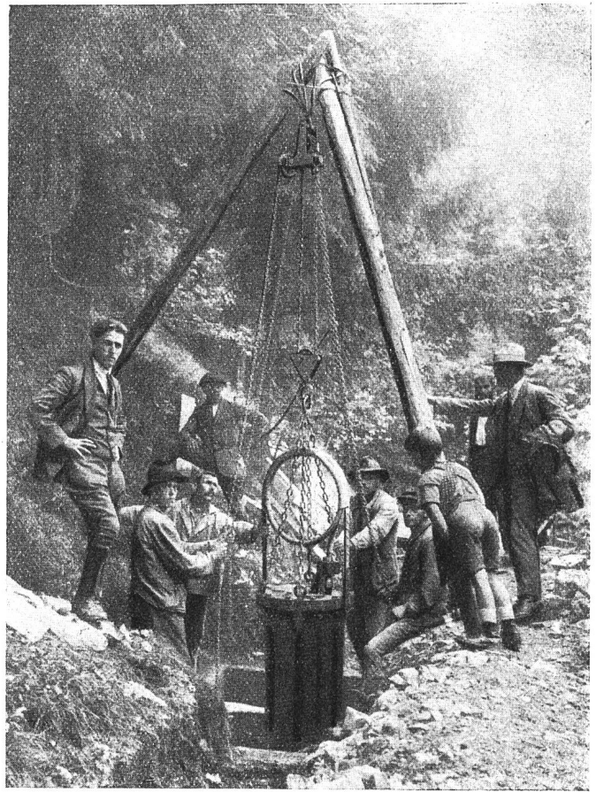
Fig. 9. Versetzen der Pupintöpfe. (Aufnahme J. Kamm.)
