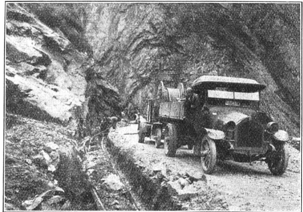
Fig. 25. Verlegung in der Piottinoschlucht.
