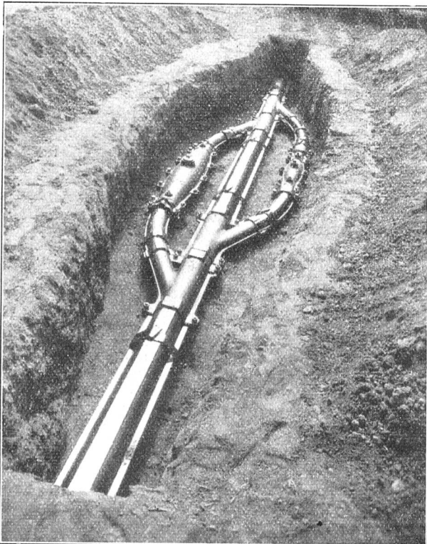
Fig. 5. Einbau der Muffen in den Zoreskanal.
