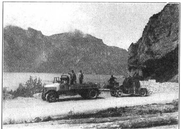
Fig. 15. Kabeltransport an der Axenstrasse.
