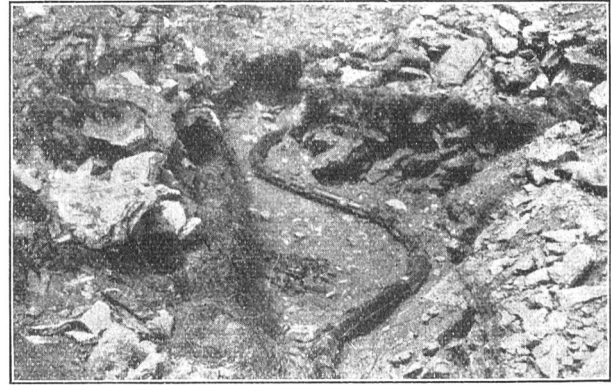
Fig. 21. Ausgleichsbogen vor einer Bachkreuzung.
