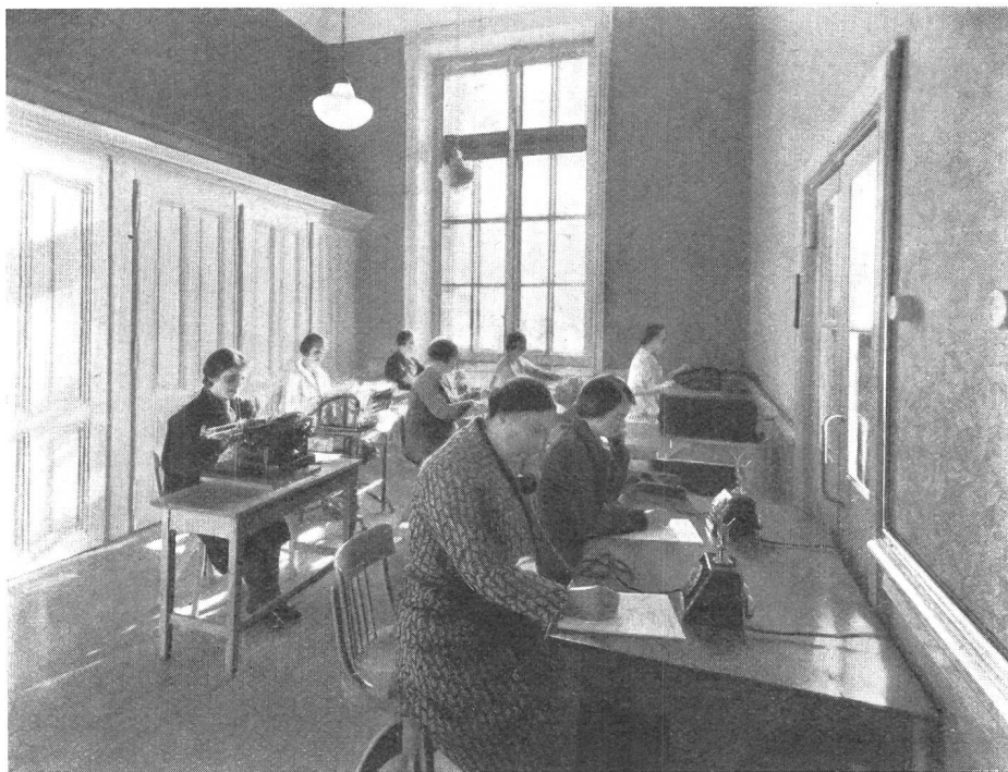
Fig. 2. Salle des machines et appareil de projection des films photographiques des compteurs.
