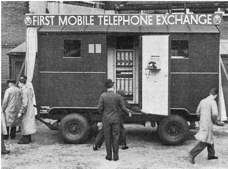
Abb. 1. Die automatische Zentrale.
