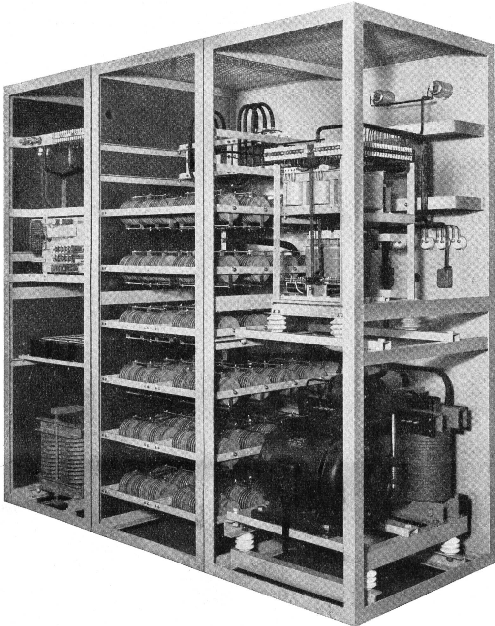
Fig. 25. Rückansicht des Gleichrichters 48 V. 360 A. Redresseur 48 V. 360 A. vu de dos.
