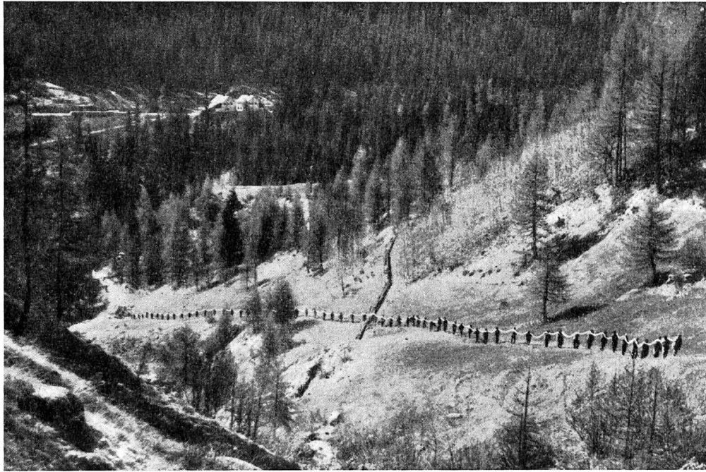
Abb. 6. Auslegung eines Fernkabels im Kanton Graubünden.
