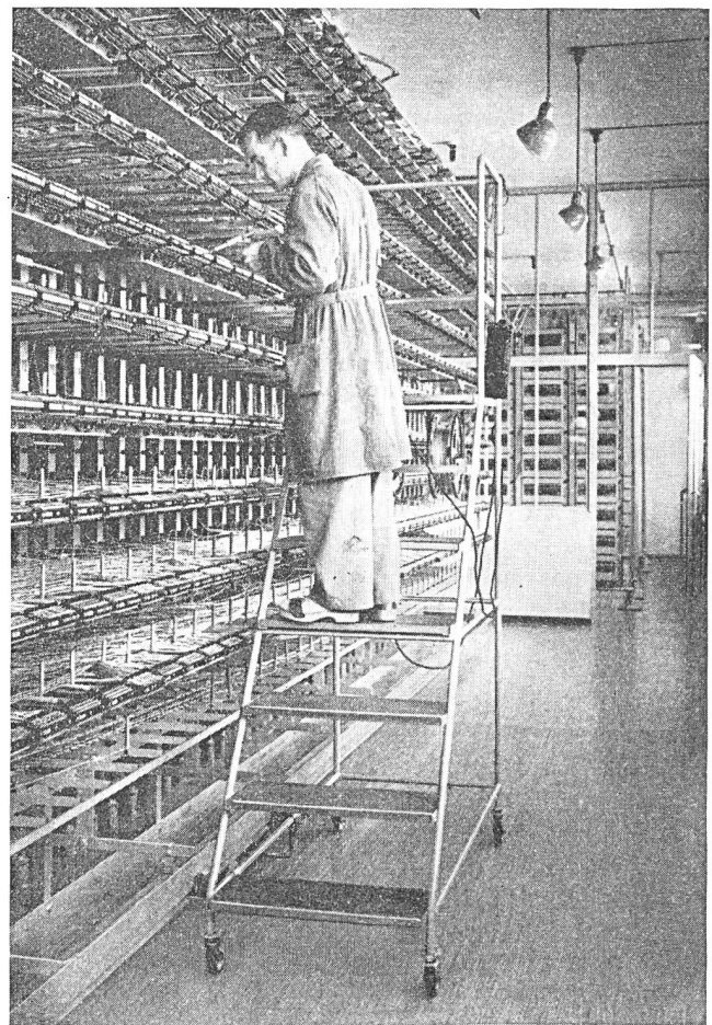
Fig. 1. Arbeiten auf der Leiter im Verteilerraum
