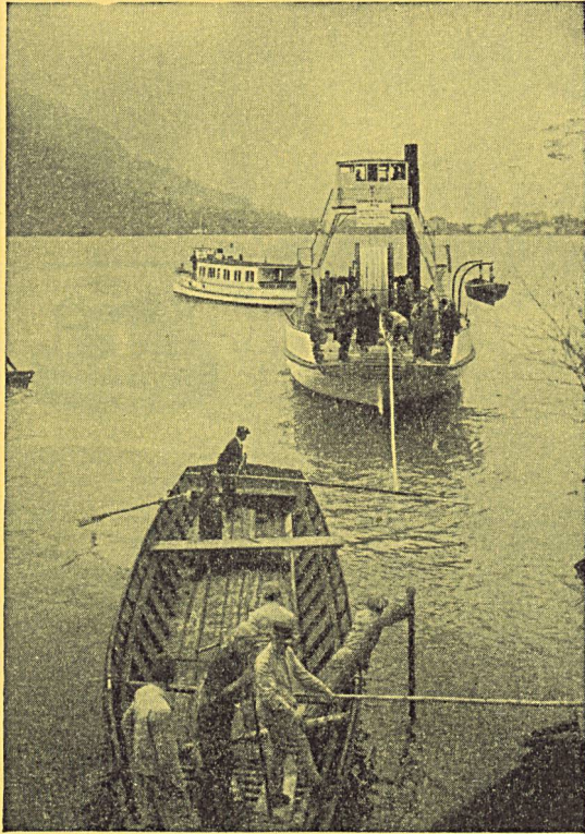
Verlegung eines Telefonkabels im Vierwaldstättersee zwischen Treib u. Brunnen für die Schweizerische Telefonverwaltung. Nov. 1935. Beginn der Kabelversenkung bei Treib.
