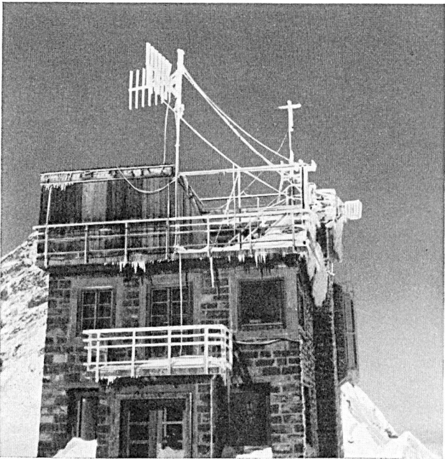
Fig. 4. Oberste Terrasse der Sphinx, gegen die Jungfrau gesehen; zuoberst Winkelreflektor-Antenne für den 2-m-Empfänger. Mitte rechts: Empfangsantenne für 1-m-Feldstärke-Registrierung des Chasseral-Senders
