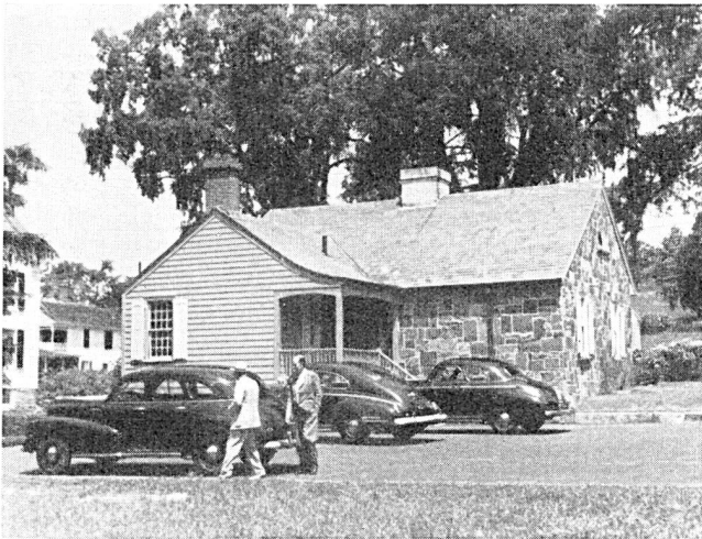
Fig. 17. Central automatique rural à Deep River, Connecticut
