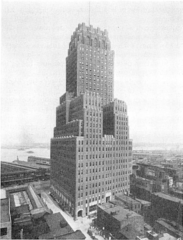
Fig. 15. Bâtiment de la direction et de l'exploitation de la «New York Telephone Company», 140th West Street à New-York
