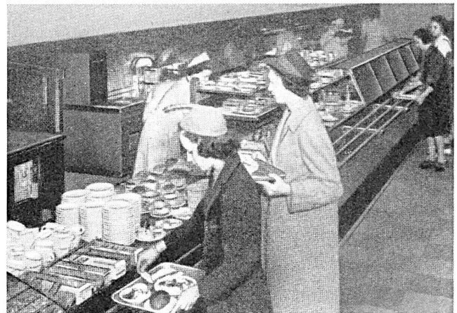
Fig. 22b. Cafeteria dans le sous-sol du bâtiment 140th West Street de l'ATT, New-York
