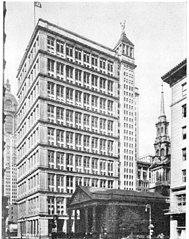
Fig. 14. Bâtiment de la direction de l'ATT, 195 Broadway, New York City
