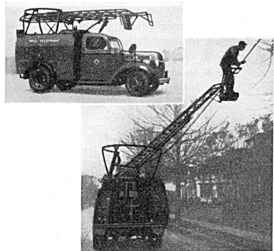
Fig. 38a. Camionnette avec échelle extensible pour le service de réparation et d'entretien des lignes aériennes
