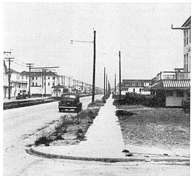
Fig. 42b. «Dropwire» fixé aux poteaux de la lumière électrique
