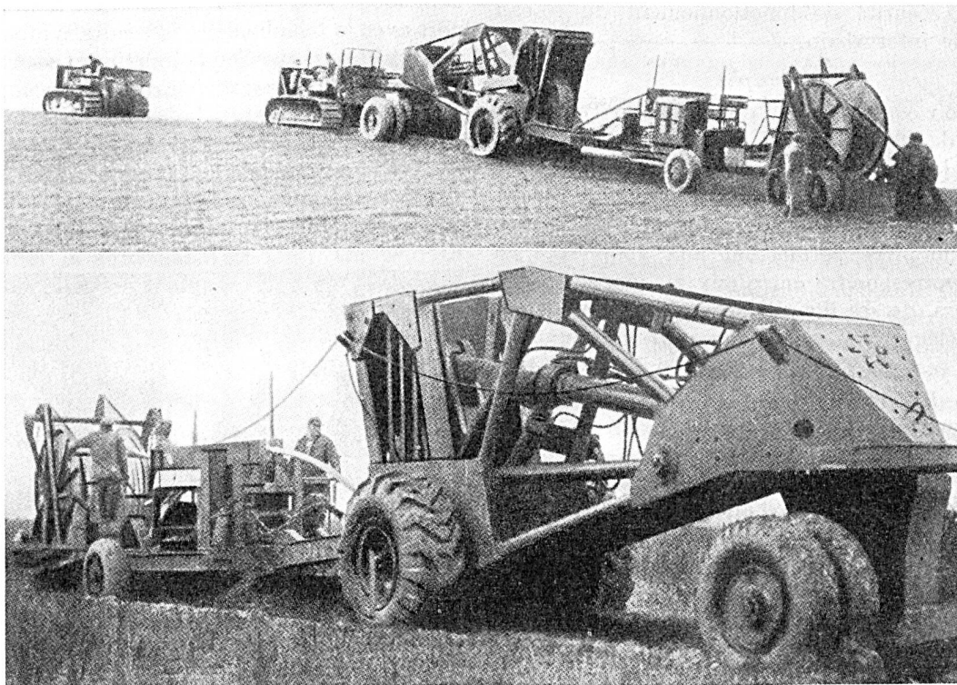
Fig. 48. Bêche-poseuse utilisée pour enterrer les câbles téléphoniques
