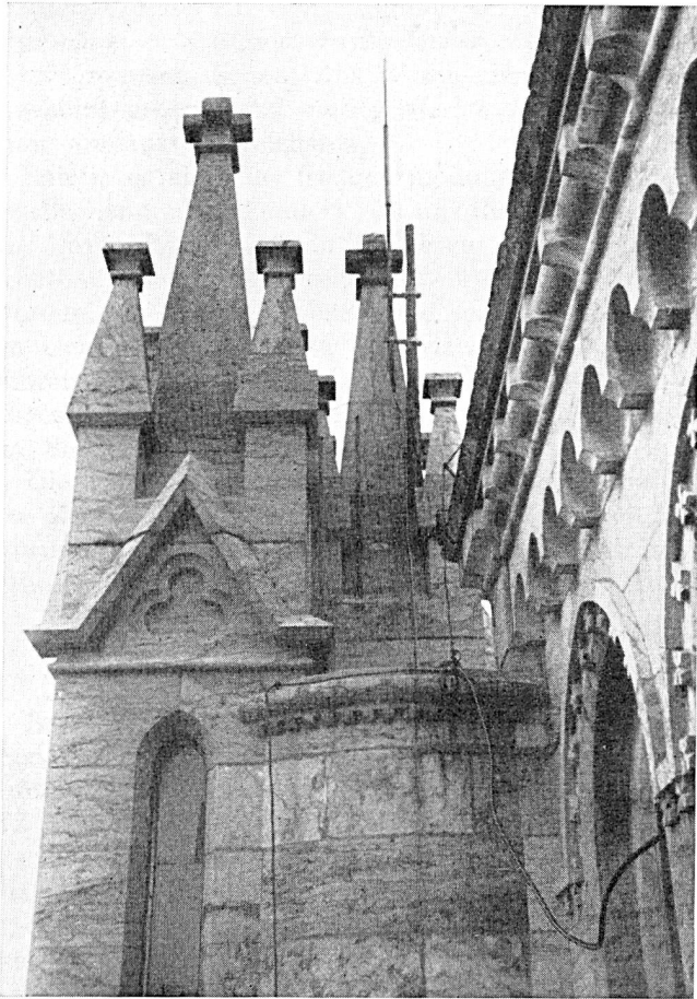
Fig. 3. Befestigung des vertikalen Sendedipols
