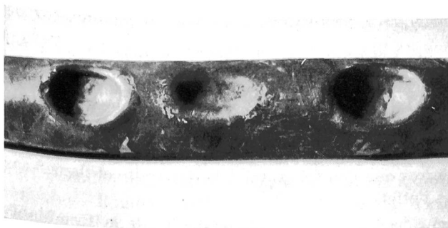
Fig. 11. Durch Eisbildung deformierter Bleimantel des Gotthardkabels, das in einem Zoreskanal Nr. 4 untergebracht war. Câble du Gothard logé dans un canal zorès No. 4 et déformé par la glace.
