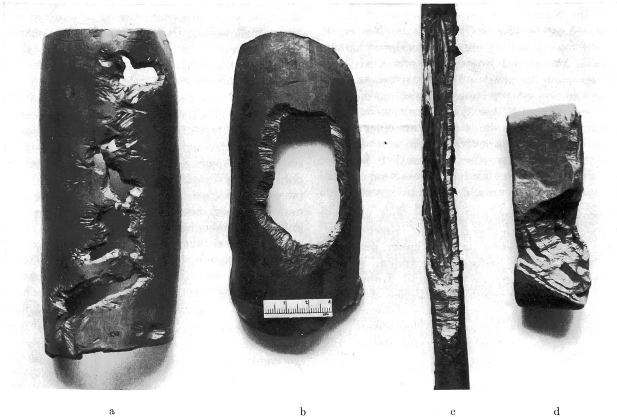
Fig. 10. Durch Nagetiere verursachte Kabelschäden — Endommagements causés par des rongeurs
