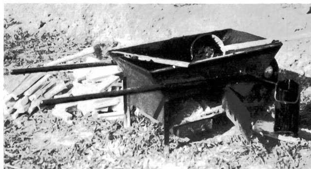
Fig. 2. Heizbare Karrette, in welcher der Muffenkitt dünnflüssig gemacht wird Brouette chauffante servant à rendre le mastic fluide
