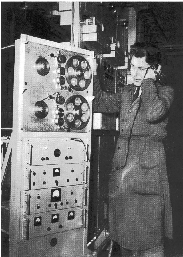
Fig. 3. Sprechmaschine mit zwei getrennten Bändern (Prototyp) Machine parlante avec 2 bandes distinctes (prototype)
