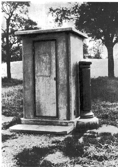
Fig. 3a. Betonhäuschen für Leitungsdurchschalter mit Verteilkasten Abri en béton pour connecteur de lignes, avec armoire de distribution
