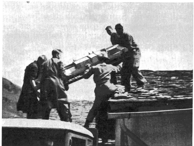
Fig. 5. Erschwerter Zutransport der Automatengestelle
