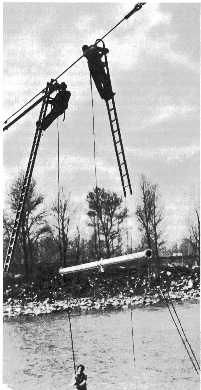
Fig. 14. Esecuzione del montaggio Ausführung der Montagearbeiten
