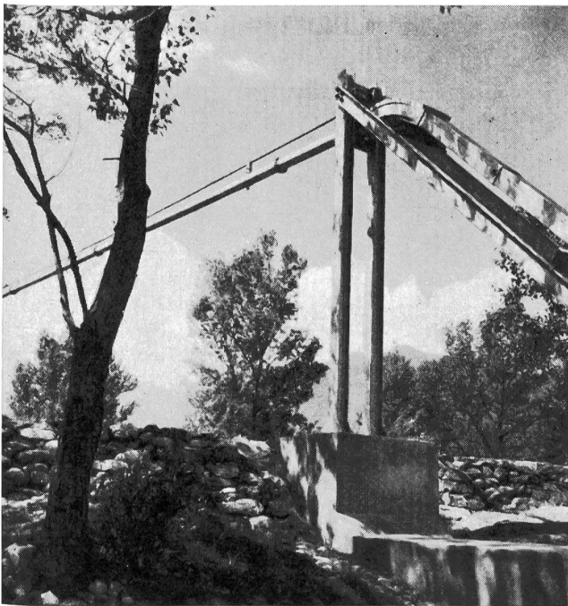
Fig. 3. Sostegno B, veduta generale Stützpunkt B, Gesamtansicht
