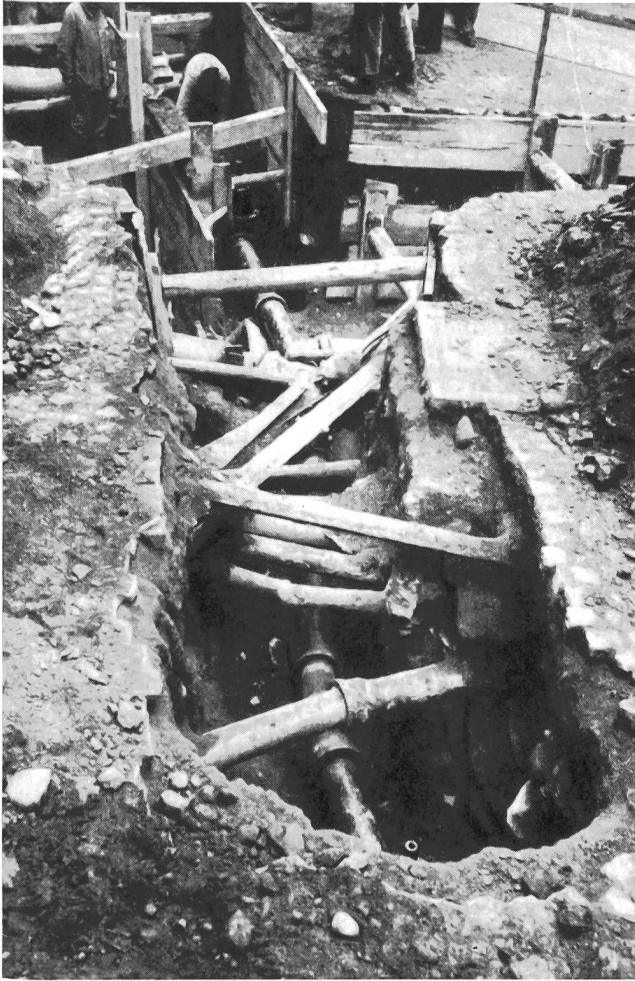
Fig. 9. Labyrinth unter der Strasse, freigelegte Werkleitungen
