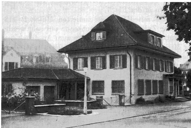
Fig. 2. PTT-Gebäude in Sumiswald Parterre: Post; I. Stock: automatische Zentrale Bâtiment des P.T.T. à Sumiswald Rez-de-chaussée: poste; 1 er étage: central automatique
