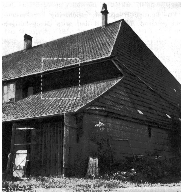
Fig. 4. Wie die alte Zentrale Koppigen, so wurde auch die neue im Dachstock dieses Hauses untergebracht L'ancien central téléphonique de Koppigen était installé dans les combles de cette maison
