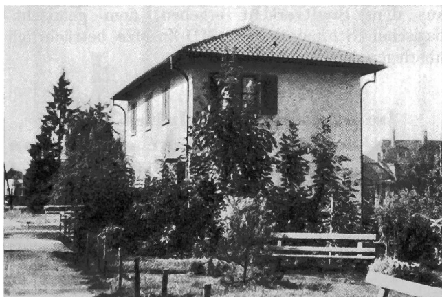
Fig. 3. TT-Gebäude in Kirchberg Parterre: Trägeramt; I. Stock: automatische Zentrale Bâtiment des T.T. à Kirchberg Rez-de-chaussée: station d'équipements à courants por-teurs; 1 er étage: central automatique
