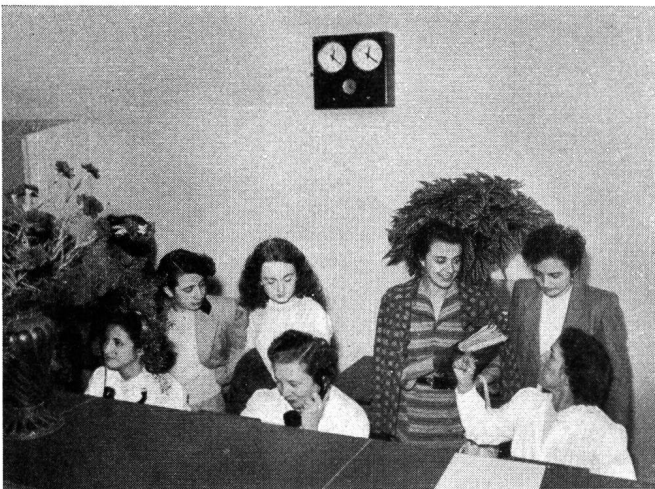
Fig. 16. Es ist 12 Uhr 20. Die «arbeitslos» gewordenen Telephonistinnen beobachten die Arbeit am Störungspult der neuen Zentrale
