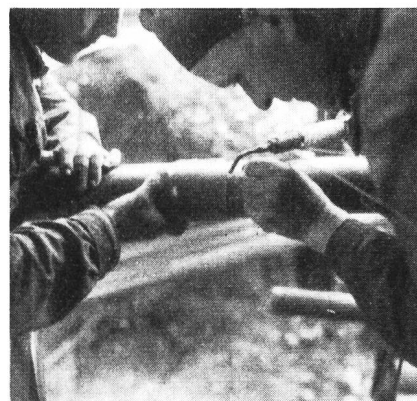
Fig. 9. Schweissen eines Somoplasrohres mit warmer Luft Soudage à l'air chaud des tubes de somoplas
