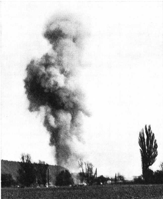
Fig. 11. Die Sprengung des oberen Teiles des Bohrschachtes Destruction de la partie supérieure du puits de forage
